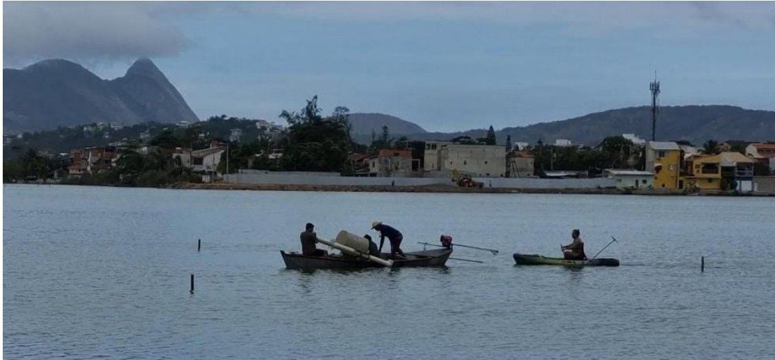
Figura 3.18 – Instalação de um PULMÃO na Laguna de Piratininga.
