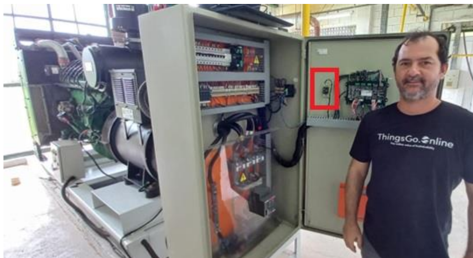
Figura 2.15 - Gerador da CHP Brasil de (230 kWh) e, na área destacada em vermelho, o dispositivo Joker (Crédito: Marcos Rangel Gonçalves Jr.).
